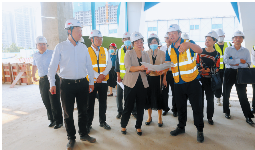
谢京副省长在工地现场查看工程进展。
